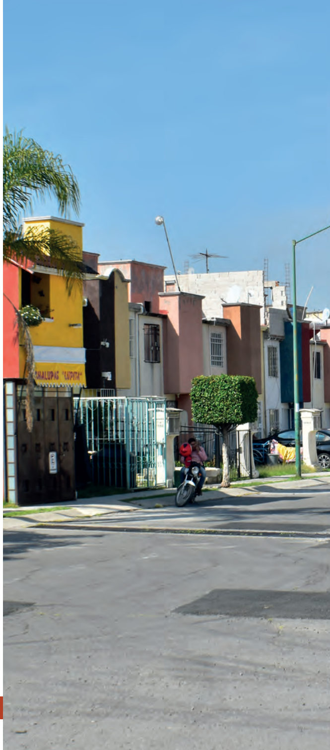
Conjunto habitacional Angeles del Sur, Puebla.
